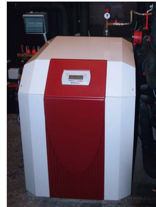
L'installation de la pompe à chaleur géothermique Simplex SI 18 TU – distribuée dans notre pays par Engels/Thermo Comfort – a été assurée par Renewable Heating Concepts.
