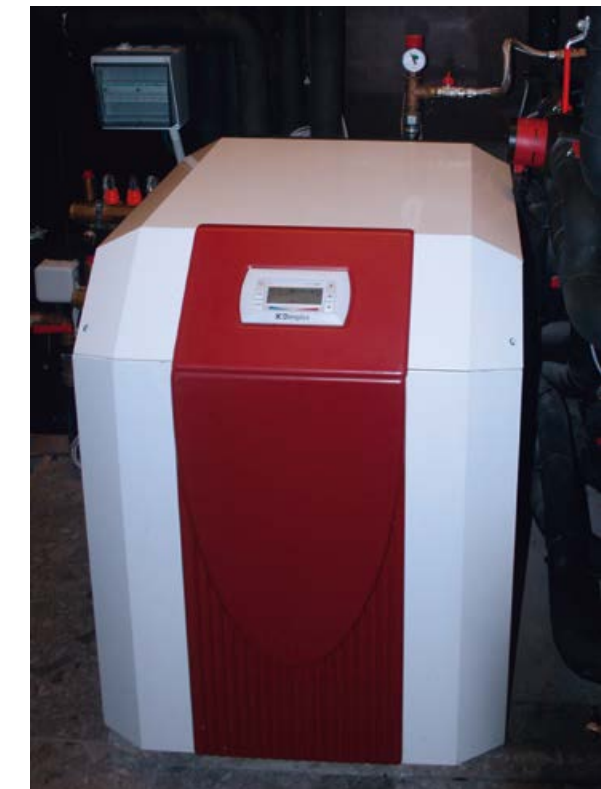
De installatie van deze geothermische SI 18 TU-warmtepomp van Dimplex – in ons land verdeeld door Engels/Thermo Comfort – gebeurde door Renewable Heating Concepts.
