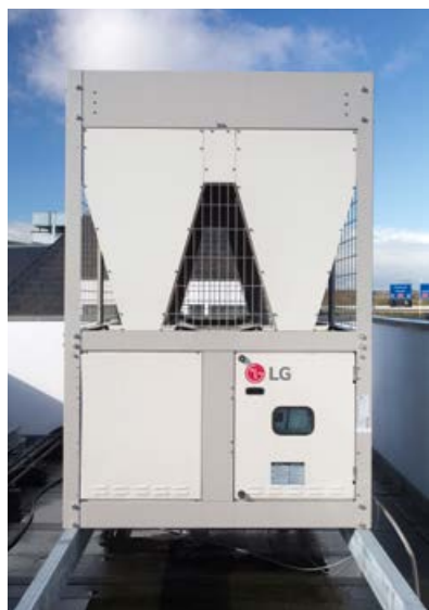
La nouvelle pompe à chaleur-chiller LG dans un montage test.
