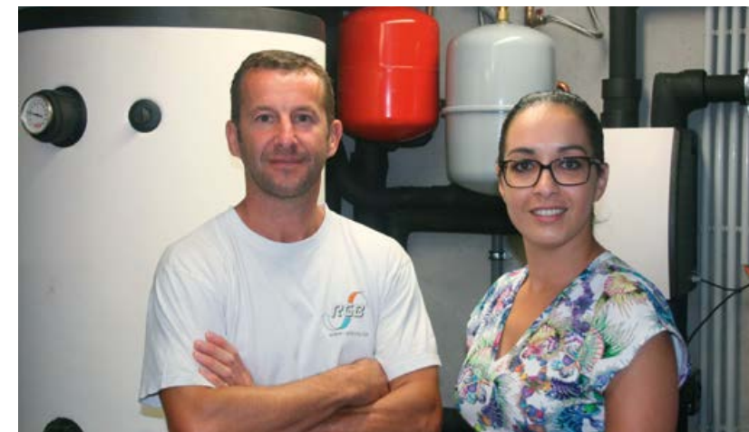
< Raf Geerts de l'entreprise d'installation RGB et Sahira Boutkabout de Thermo Comfort – Engels.
