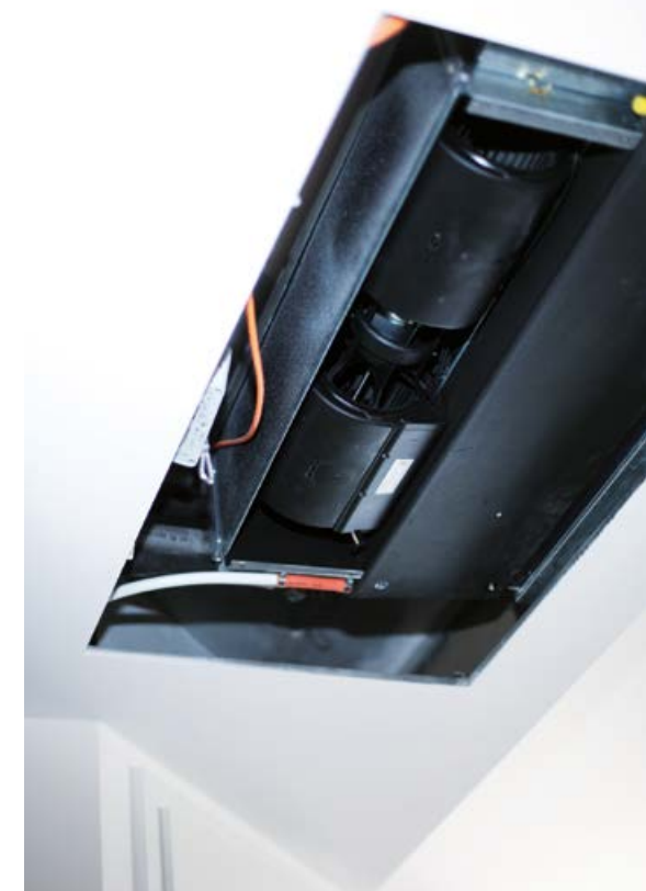
Figure 5 : Les ventilateurs centrifuges EC conviennent parfaitement pour les ventilo-convecteurs.
