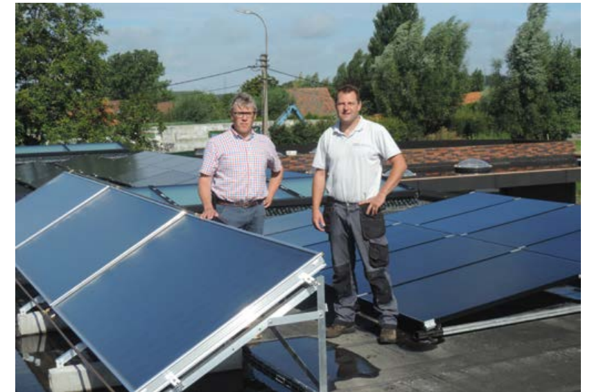
Geert Gallet (Climapac) et Peter Vanbellegheem (Ensol-Tec) entre les panneaux solaires disposés sur le toit.
