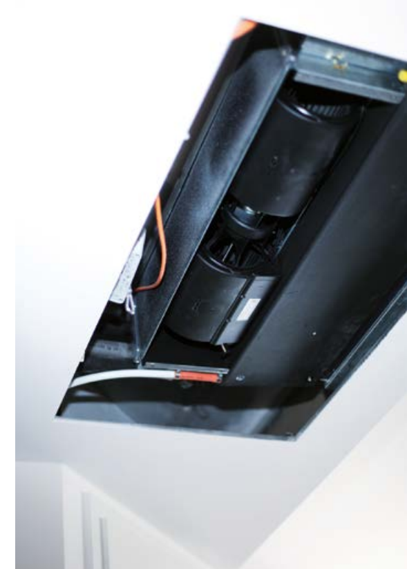
Figuur 5: De EC-centrifugaalventilatoren zijn ideaal voor toepassingen in fancoilunits.
