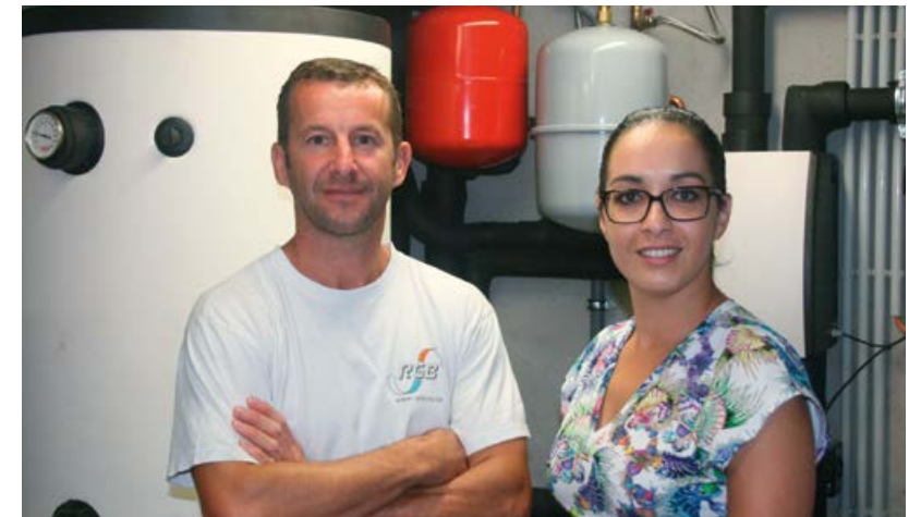
< Raf Geerts van installatiebedrijf RGB en Sahira Boutkabout van Thermo Comfort – Engels.
