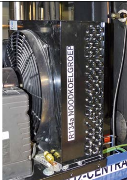
Bij storing neemt een Tecumseh-noodkoelgroep met R134a de koeling van het CO 2 -vloeistofvat over.
