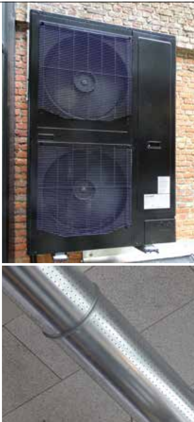
La plage de fonctionnement de la pompe à chaleur air-air FDC250VSA de la série PAC s'étend de -15°C à 50°C.
