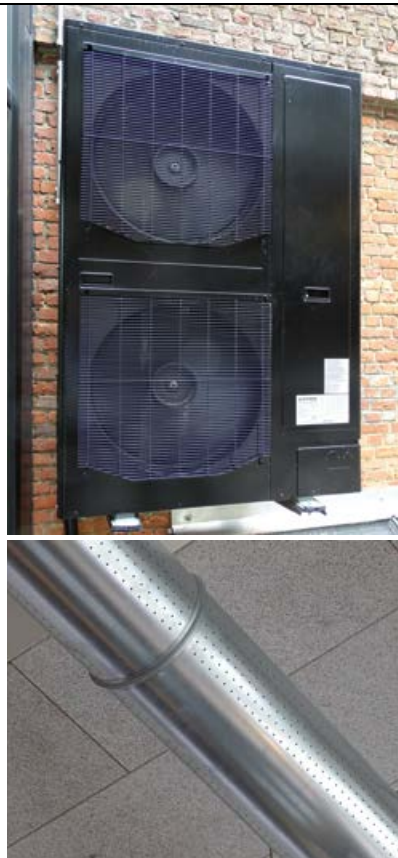
Klimagiël gebruikt een Computational Fluid Dynamics-programma voor berekening van de perforaties in de Metal Jet.
