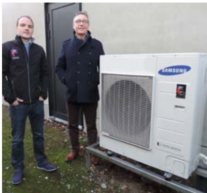
Jonas et Guy Staelens auprès de la pompe à chaleur air/eau Samsung.
