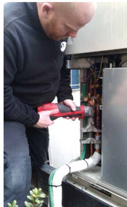
Een installateur die gewoon is om leidingen te plaatsen voor sanitair of verwarming kan via Vulkan Lokring zonder probleem ook koeltechnische leidingen plaatsen.
